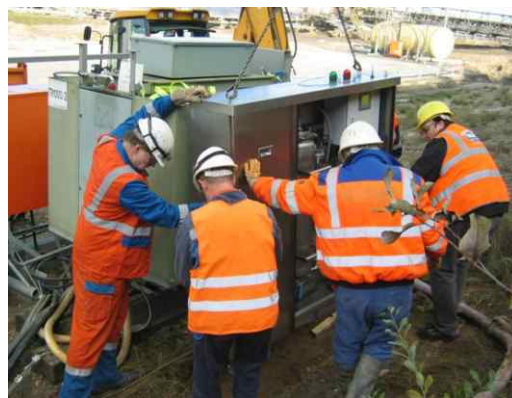
Installation des ATMoS im Feld
