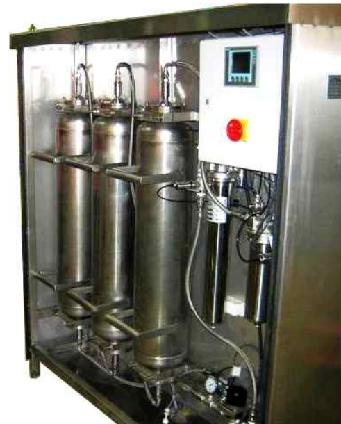
ATMoS mit den Optionen Feuchte-/Temperatursensor, großer Partikelfilter, Industrie-SPS mit Touchpanel und Leckageüberwachung (Wetterschutzgehäuse, Tropfwanne und Leckagesensor)
